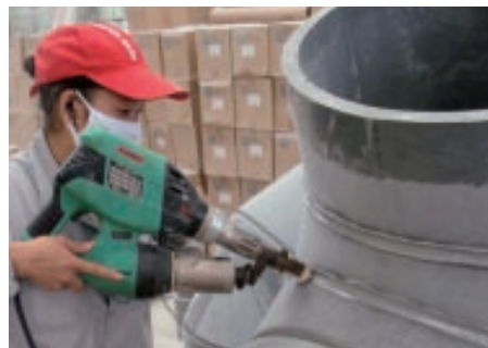
Extrusionsschweißen eines Rohrbogens einer Leitung mit WELDPLAST S2 PVC.
