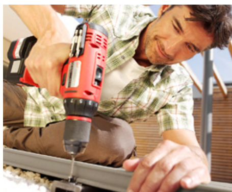
Live-Verlegung einer WPC-Terrasse bei der Garten Tulln Bild: REHAU
