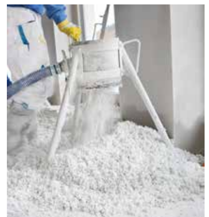
Das Dämmsystem aus Recyclingstyropor wird im ThermoWhite®-Mixmobil gemischt.
